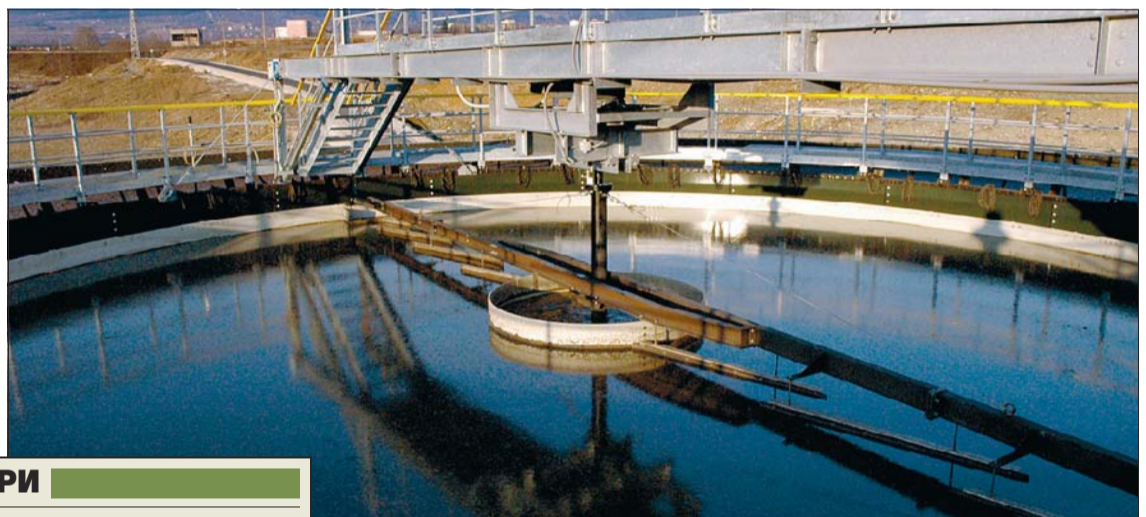
Отпадните води от канализацията се събират в биобасейн, който ги пречиства окончателно.
